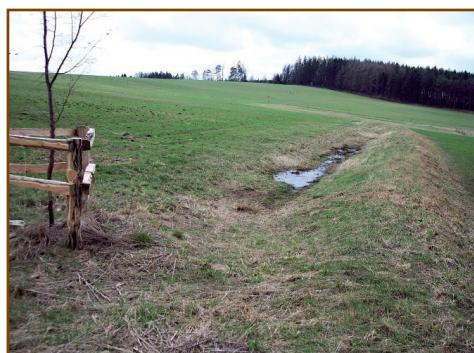
Obr. 3.19 Průleh (Milínov, foto VÚMOP, v.v.i.)
